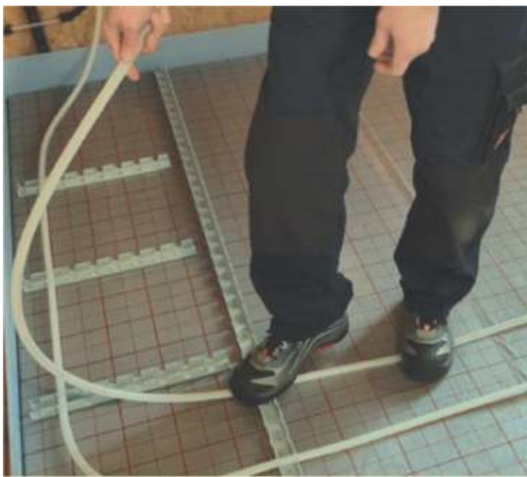
Schienenverlegung
